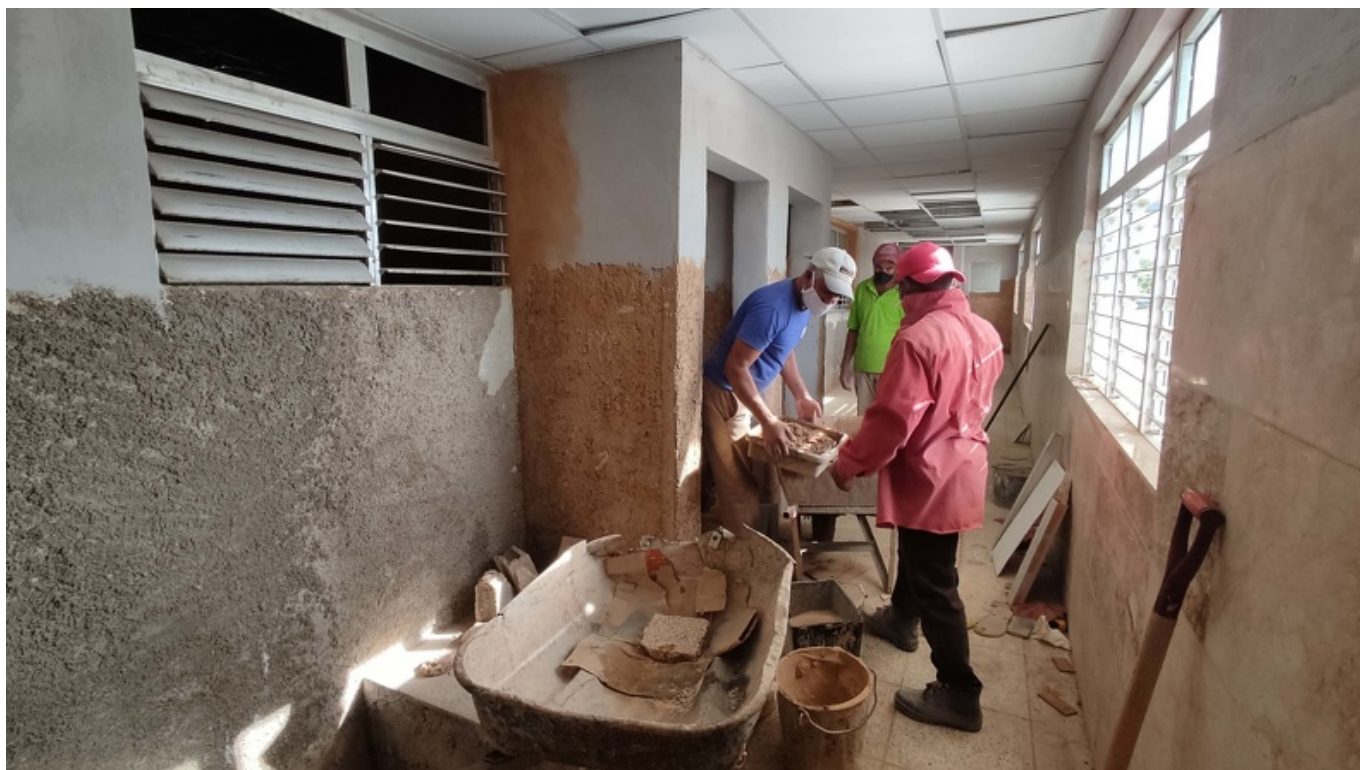
Acciones constructivas en el Hospital Faustino Pérez.
